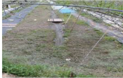
배수 불량(배수구에 물이 고여 있음)
