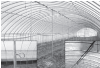
보강지주 설치 전경
