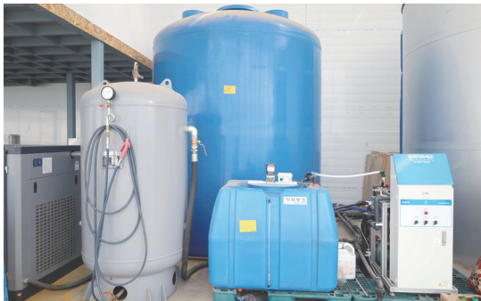
균일한 품질의 딸기를 생산하기 위해 설치한 스마트팜 제어시스템. 초미립자 안개를 분무해 온습도를 조절하고 엽면시비를 할 수 있는 에어포그를 사용해 4,628㎡ 규모의 재배동을 관리하고 있다.
